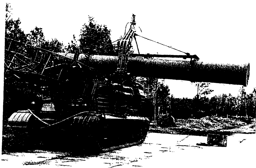
Самоходный стартовый агрегат (объект 803) — загрузка ракеты
