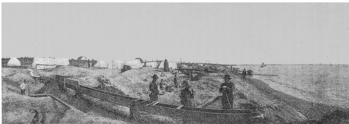
Разработка береговой россыпи: промывка на шлюзах.
