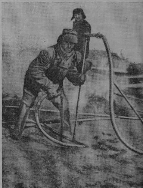
Отогревание скважин в вечной мерзлоте паровой иглой
