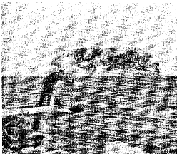
3) Гидрометеоролог Тихонов измеряет уровень воды
