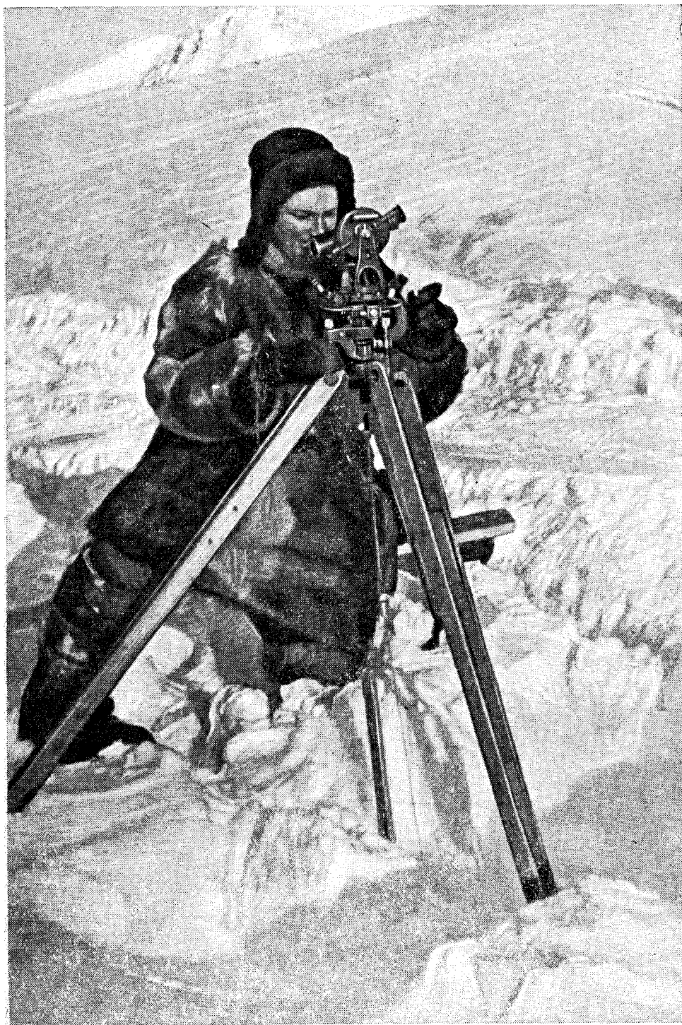
На строительстве порта в бухте Провидения. Топограф разбивает участок
