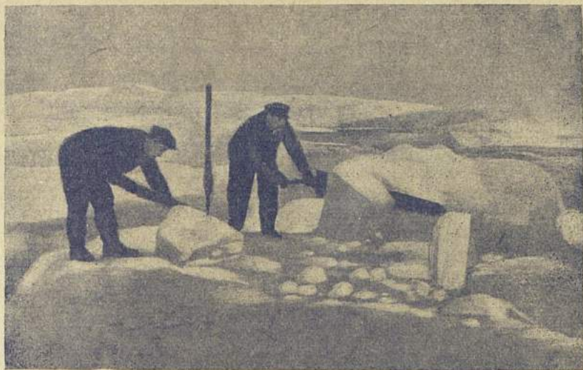
Физик Факидов и кочегар Бармин выпиливают для механических испытаний из торосов кубики льда.
