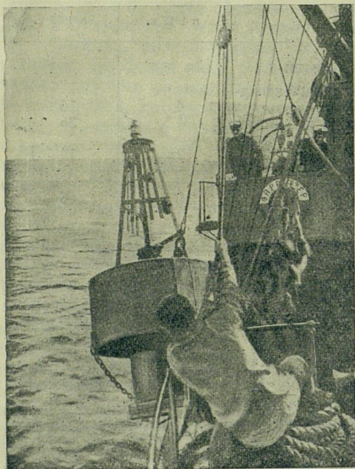
Постановка освещаемого буя для ограждения отмели (в устье Енисея).
