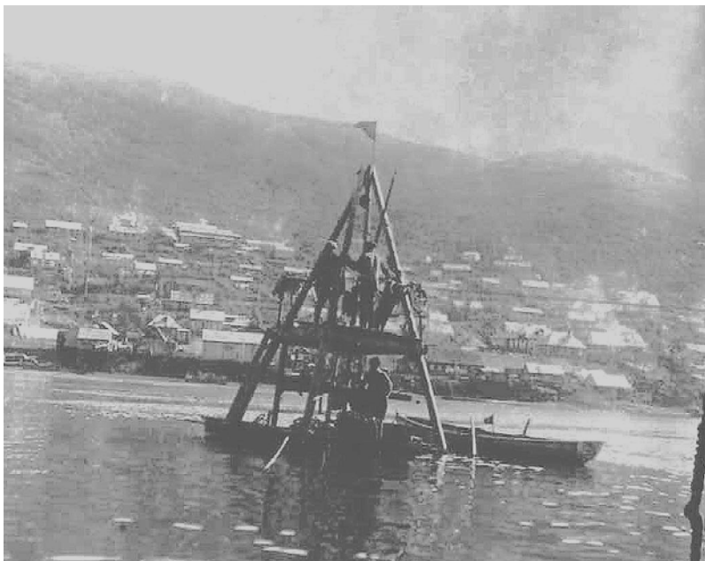
Разведочные работы на акватории Ковша. Плавучая бурильная установка, 1936 г. (из фондов ГАКО)
