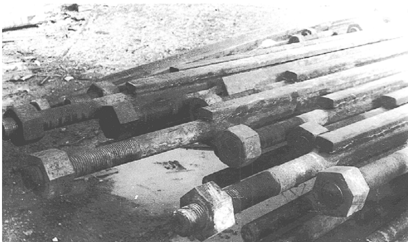
Самодельные резьбовые наконечники для анкерных связей, изготовленных из рельсов (из фондов КОКМ)
