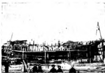
Сумский посад. Обшивка шпангоутов (ребер) вновь строящегося судна.
