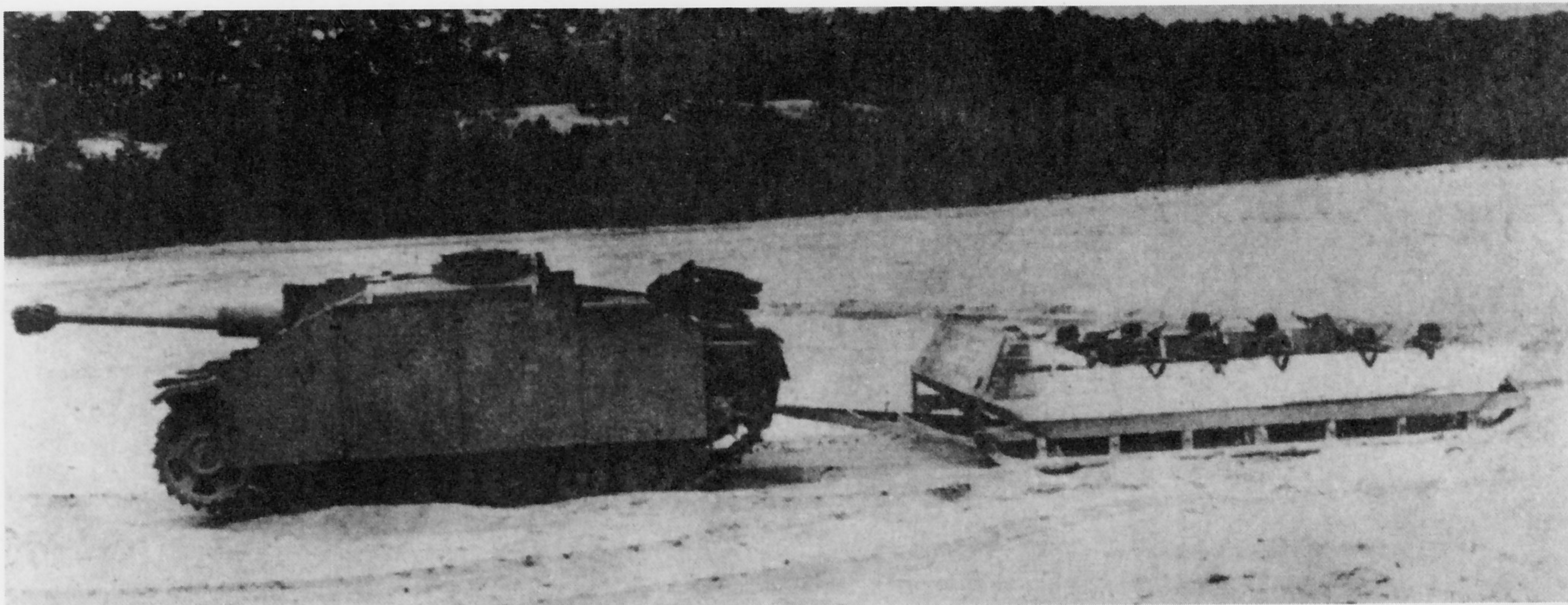
Der schwere Anhängerschlitten für Gleiskettenfahrzeuge war auf dem russischen Kriegsschauplatz äußerst selten anzutreffen. Die "Gerätbeschreibung und Anleitung zum Zusammenbau vom 5.8.1943" enthielt - aufgelistet in einer Stückliste - alle zum Bau des Schlittens benötigten Teile, Beschläge und Hölzer. Die Beschläge wurden der Truppe angeliefert. Die Hölzer mußten von dieser selbst gefertigt werden. Hier der schwere Anhängerschlitten im Schlepp eines Sturmgeschützes III
