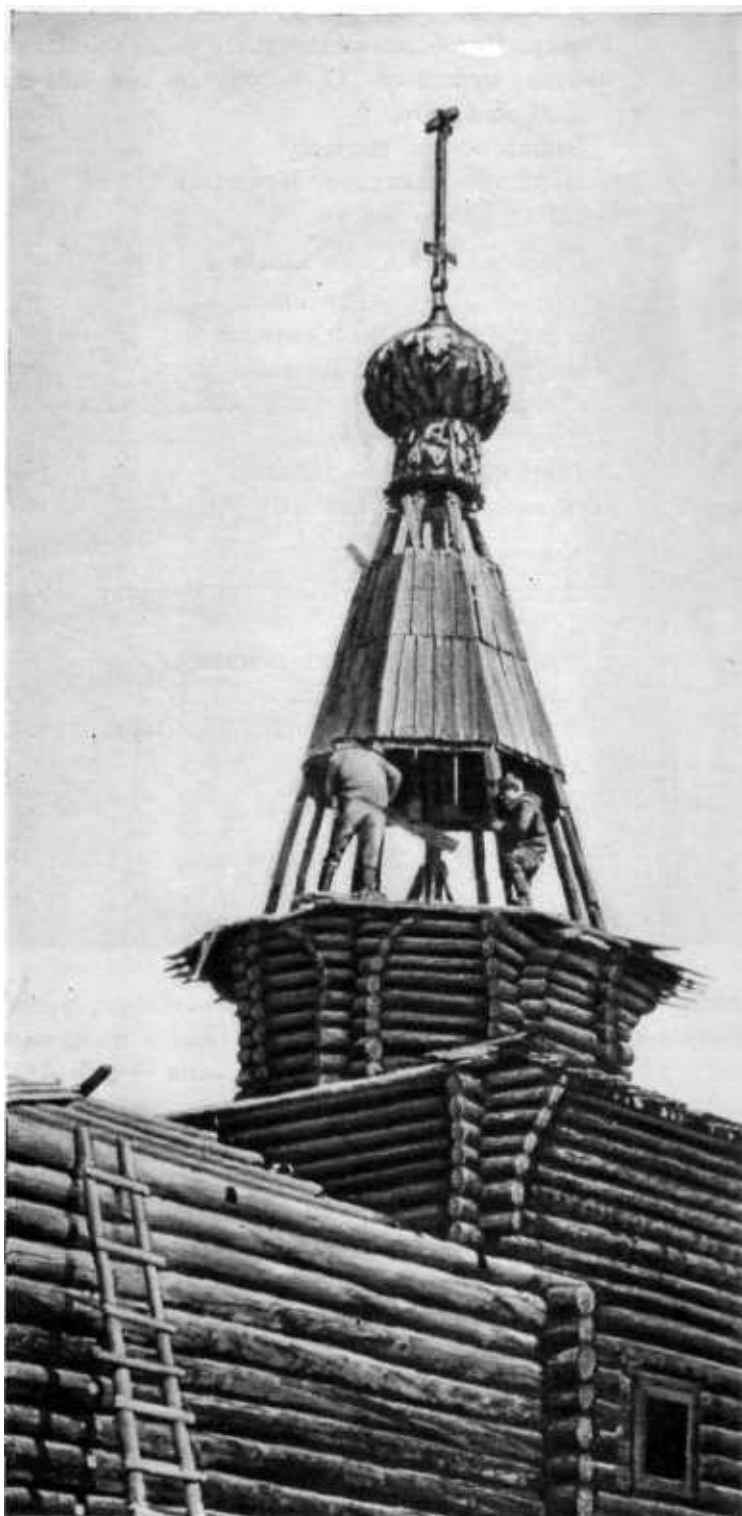
Разборка шатра Спасо-Зашиверской церкви. Завершается разборка нижней части
