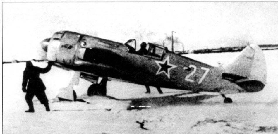
Ла-11 на взлётных лыжах выруливает на старт, март 1948 г.
